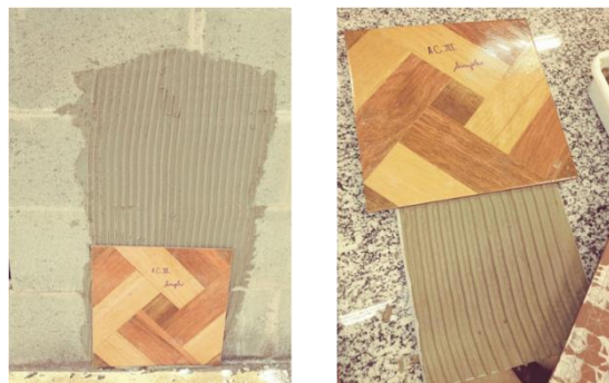
Figura 2 – Assentamento das placas cerâmicas
