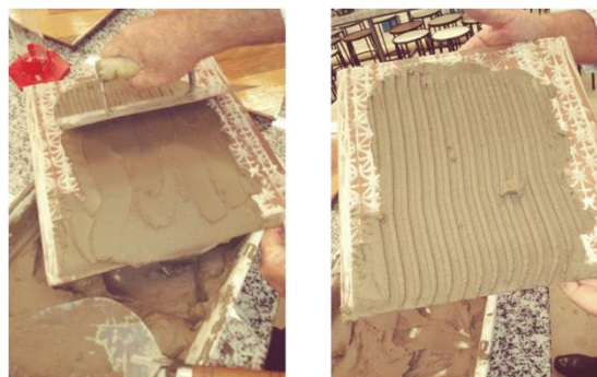
Figura 3 – Aplicação e frisamento da argamassa no verso da placa cerâmica
